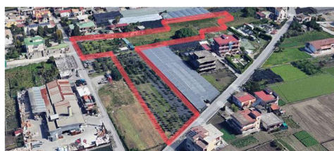
AREA 9_ Area libera presso strada Provinciale Carrara
